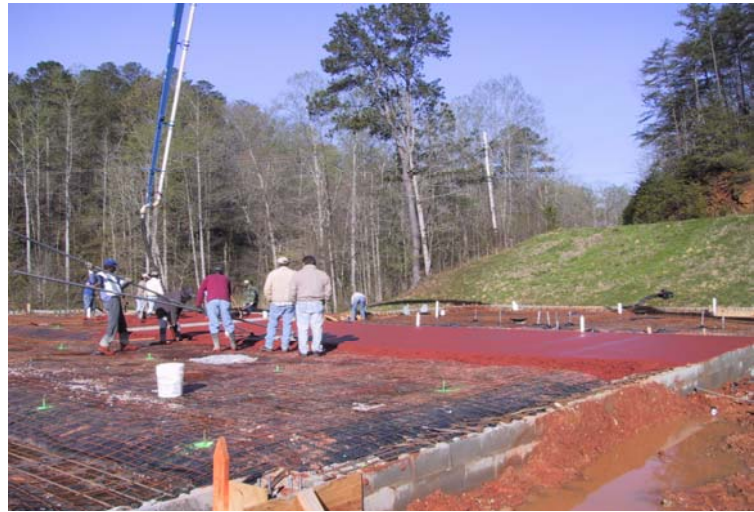
APC Canyon Rust Slab Pour
